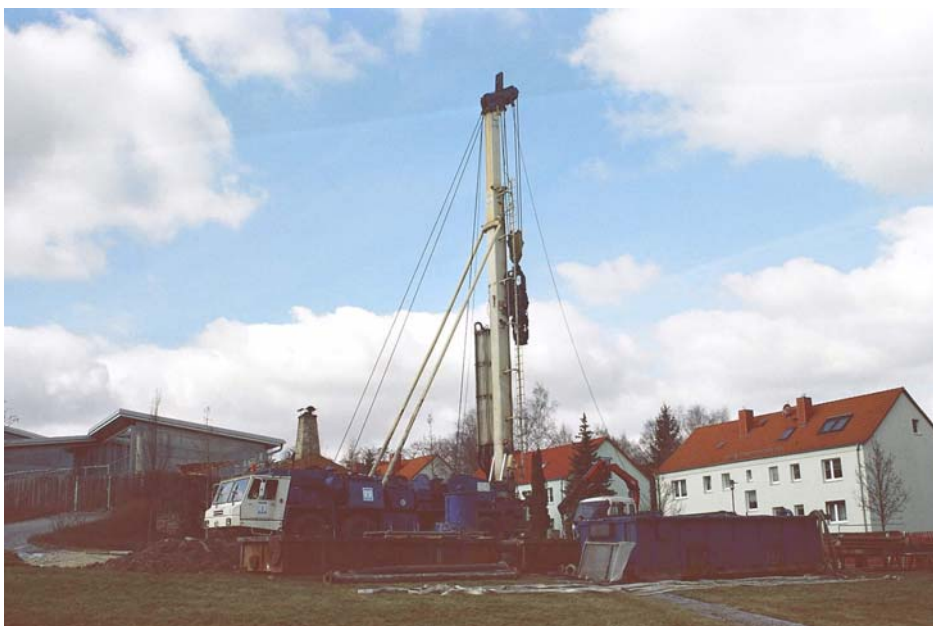
Foto: Bohranlage bei Wartungsarbeiten
